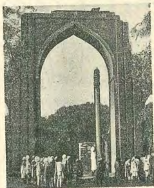
[121圖] 西曆4世紀頃に建設された印度デリー市附近の錬鉄の塔(門内に見えるもの)
